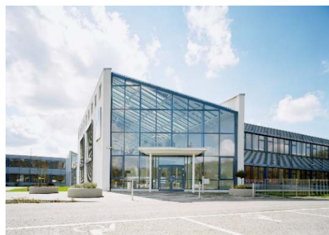
Der im Sommer 2002 fertiggestellte Erweiterungsbaubau
